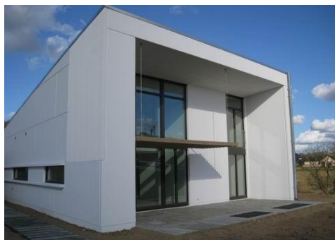
Figur 3.13: Solafskærmningen i hus 45.
