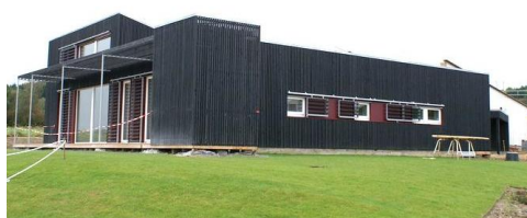
Figur 5.14: Vinduer i østfacaden, hus 39. Målinger er foretaget i værelse bag det midterste vindue i østfacaden.
