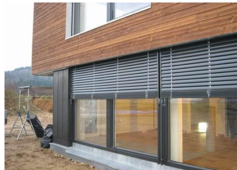
Figur 3.11: Solafskærmningen i hus 43.
