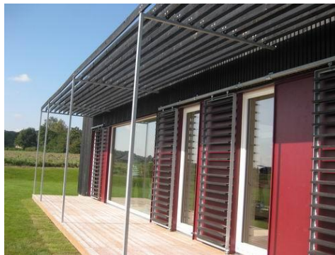
Figur 3.9: Solafskærmningen i hus 39.
